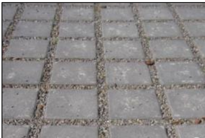
Figur 13. Exempel på genomsläpplig betongbeläggning med grusfogar.
