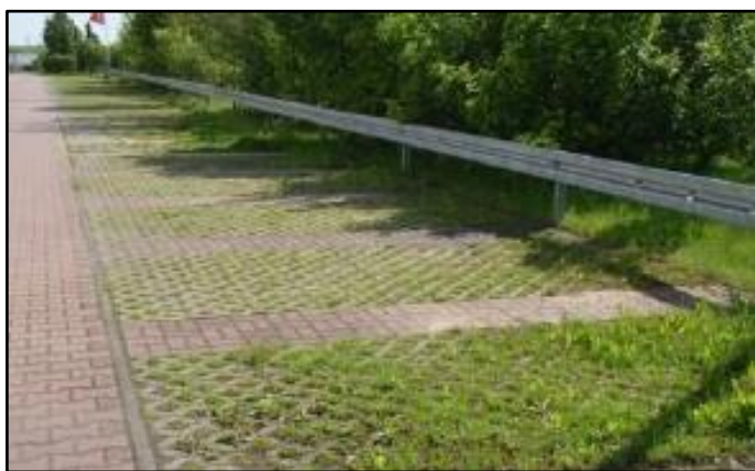
Figur 14. Exempel på genomsläpplig betongbeläggning med gräs.
