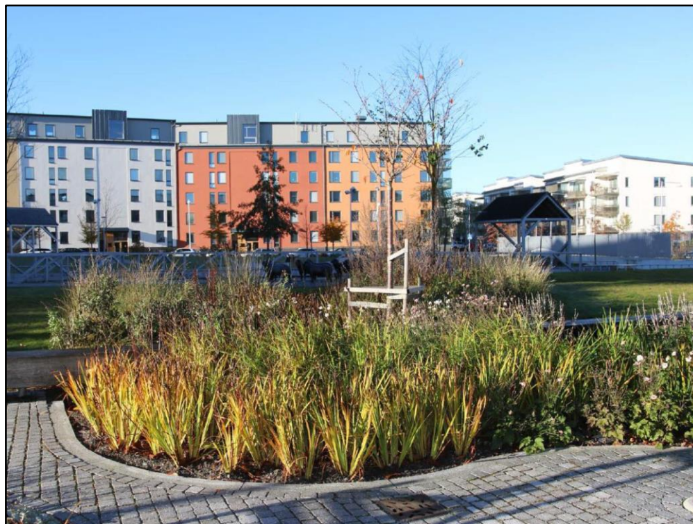
Figur 17. Exempel på nedsänkt växtbädd (Solna stad dagvattenstrategi, 2018).
