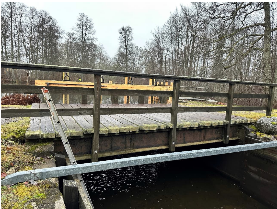
Bild 2 Bron sedd från norr
