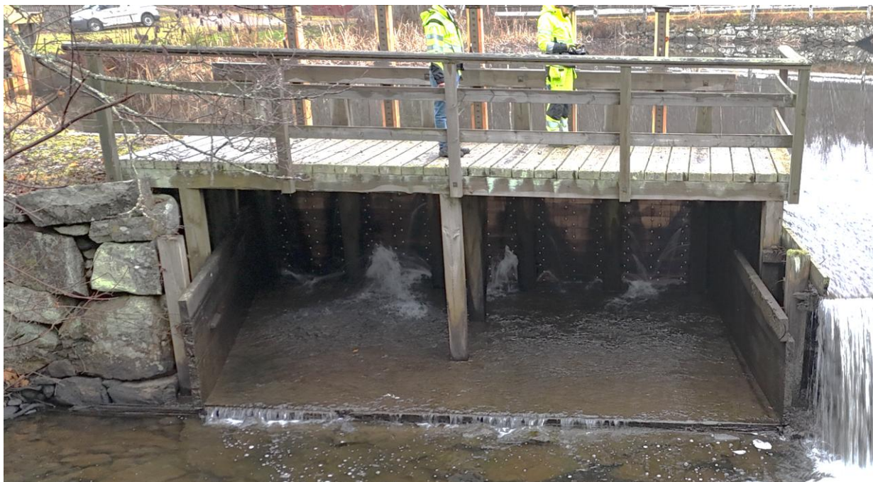
Figur 4. Dammluckorna av trä sett från nedströms sida. Foto: Tyréns
