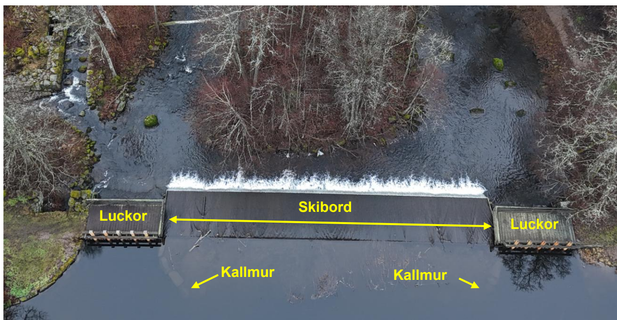
Figur 3. Dammkonstruktion med vall, luckor och skibord. Vy mot väst. Foto: Tyréns
