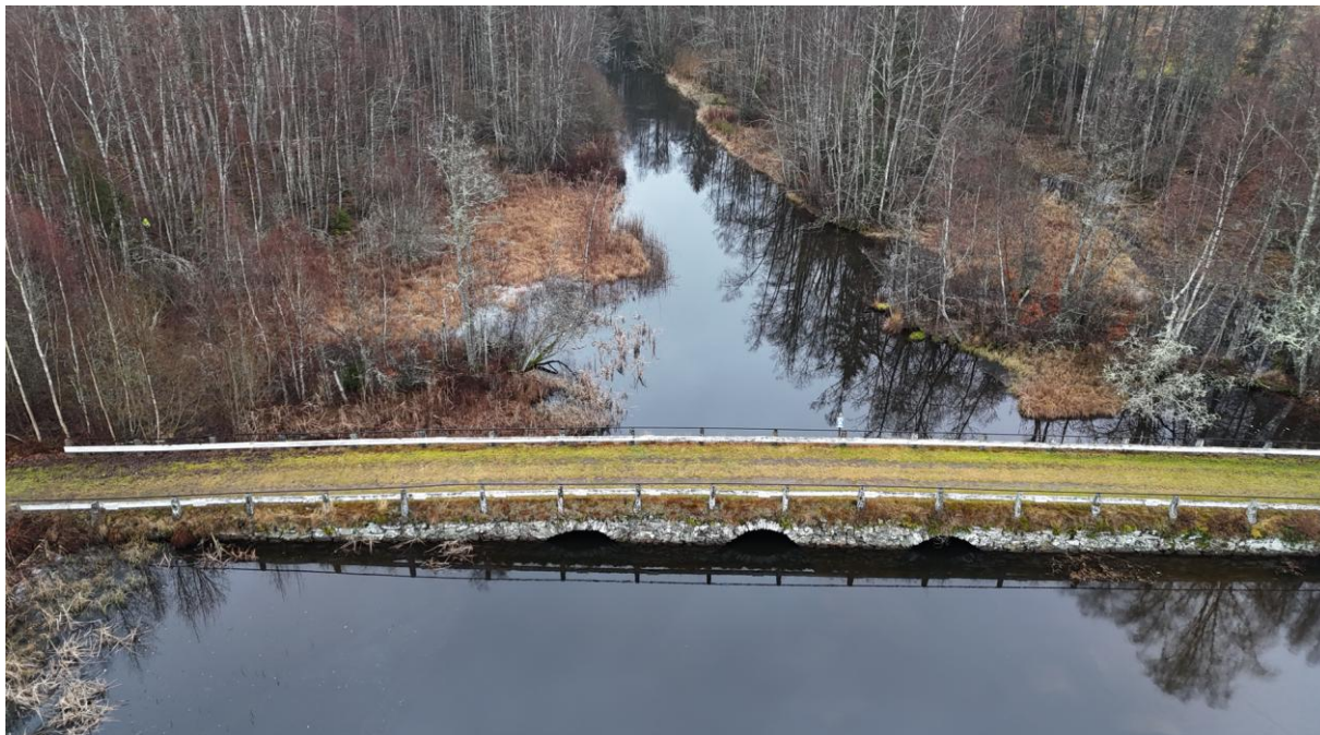
Figur 8. Bro vid inloppet på östra sidan av dammen. Foto: Tyréns
