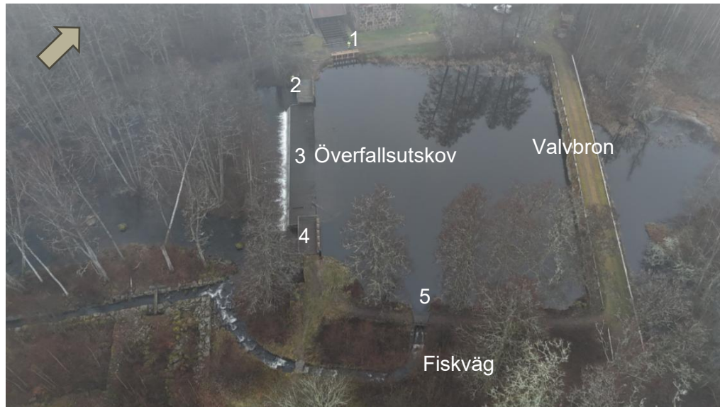
Figur 3. Översikt av dammkonstruktionen vid Vartorp. Förklaringstext av anläggning framgår i bilden. Pilen i vänstra hörnet representerar en norrpil. Löpnummer 1 – intagsluckor till kvarnhjul samt även placering av bro. 2 – Utskovsluckor som öppnas vid höga vattenflöden. 3 – Överfallsutskov. 4- Utskovsluckor. 5- befintlig fiskväg, Fotokälla: (Tyréns Sverige AB, 2024).
