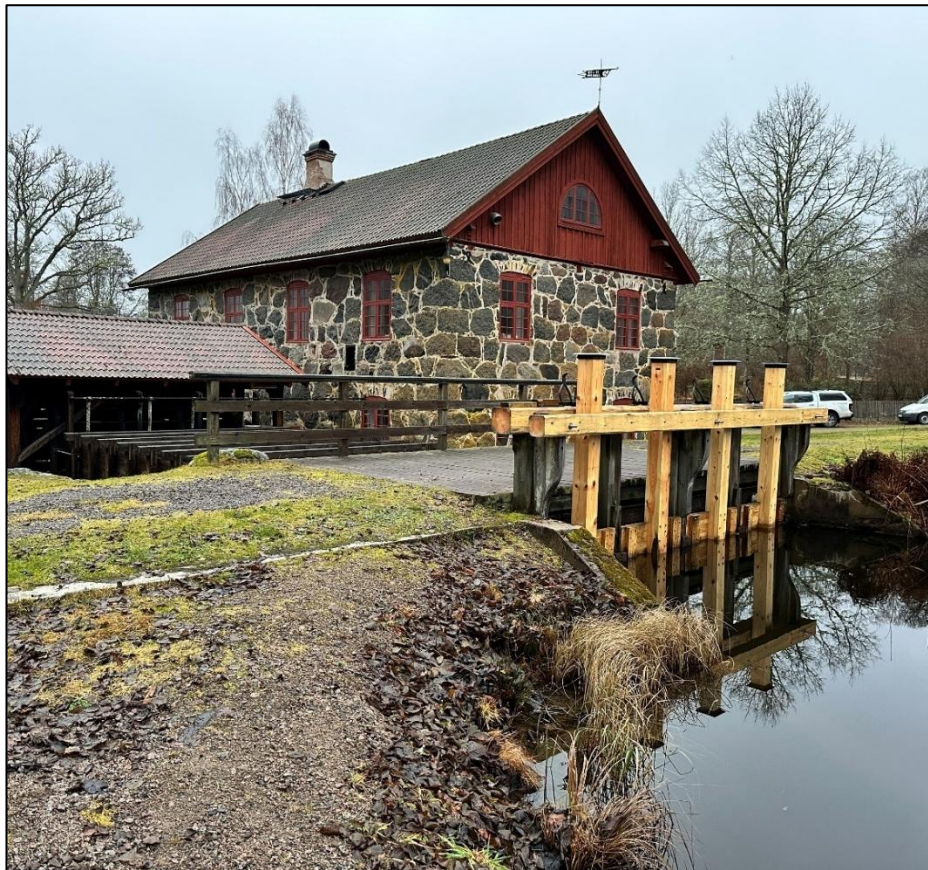
Figur 5. Bron vid intagskanalen till kvarnen. Fotokälla: (Tyréns Sverige AB, 2024)
