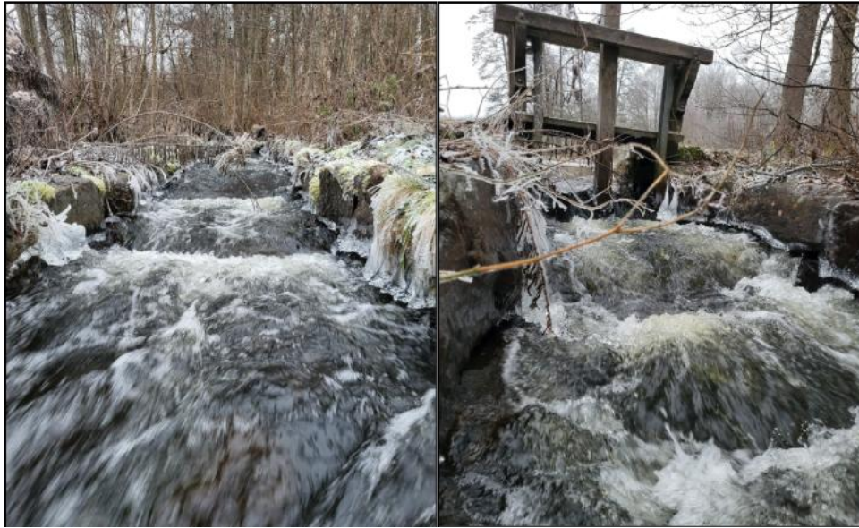
Figur 26. Fotografier i omlöpet (vänster) och vid luckutskov vid Vartorpsdammen (höger). Omlöpets konstruktion och luckutskovets utformning leder till höga vattenhastigheter och bedöms vara starkt begränsande för svagsimmande arter att passera. Foto: (Tyréns Sverige AB, 2024).
