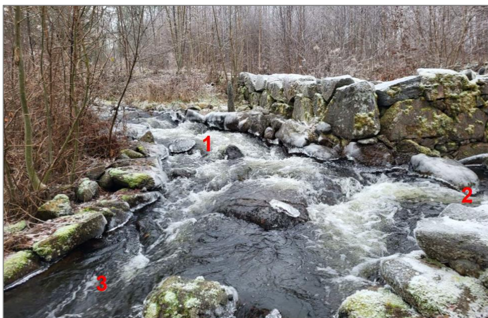
Figur 25. Fotografi omlöpets nedre del (1), ingång för uppströms vandrande fisk (2) och utskov till kanal söderut(3). Foto: (Tyréns Sverige AB, 2024)
