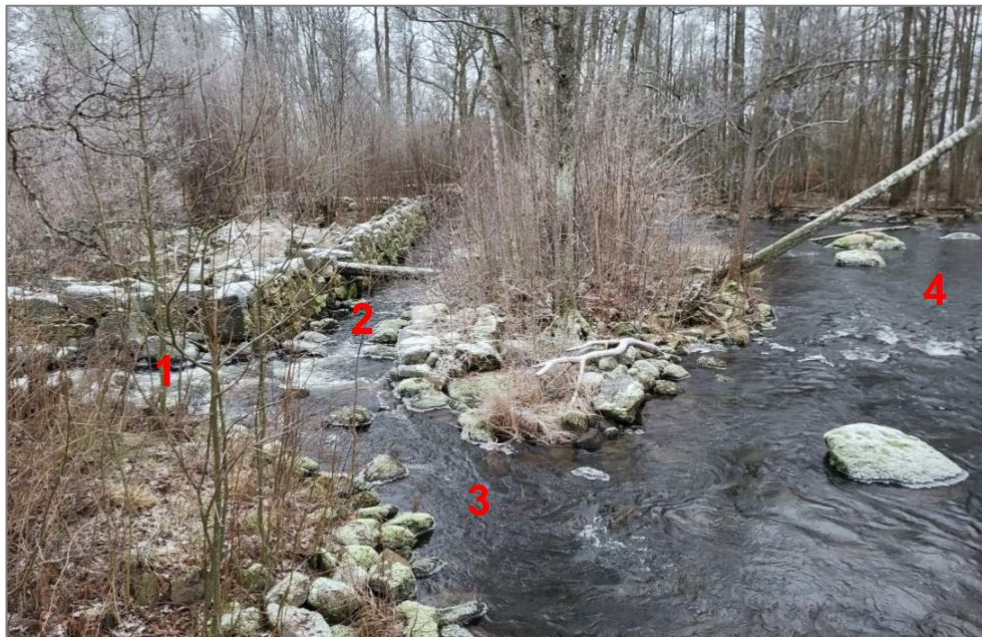
Figur 24. Omlöpets nedre del (1) vid utskov till kanal (2), fiskars ingång till omlöpet (3) för uppströms vandrande fisk (4). Foto: (Tyréns Sverige AB, 2024)
