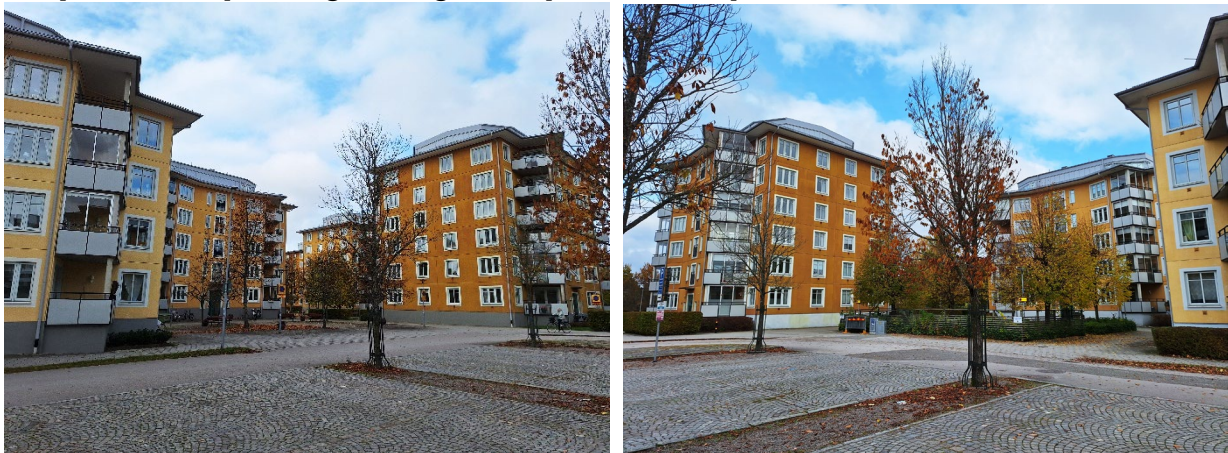
Bild till vänster visar de fem flerbostadshusen på fastigheten Björnen 10. Bild till höger visar de två andra flerbostadshusen på Kräftan 11 samt en liten del av byggnaden för aktuell ändringsplan syns till höger i bilden.
