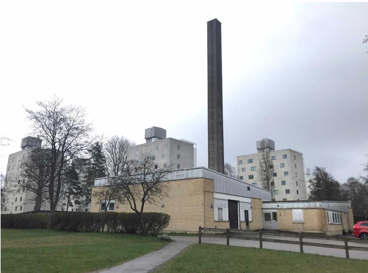
Figur 42 Panncentralen fr n 1965 med enkel gestaltning i linje med de samtida byggnaderna p  norra delen av kvarteret, Erskines byggnader i bakgrunden.
