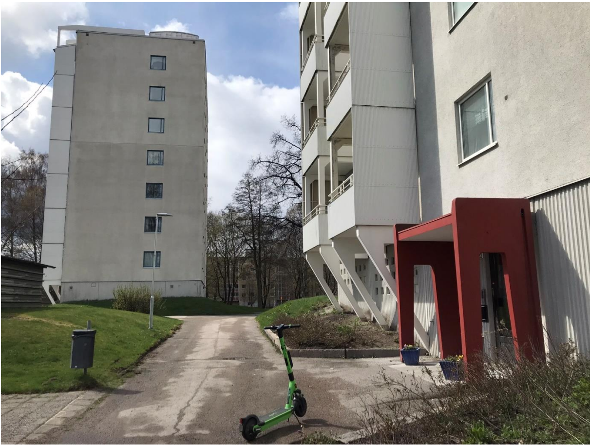
Figur 39 De fristående entréportalerna med skärmtak har en skulptural gestaltning.
