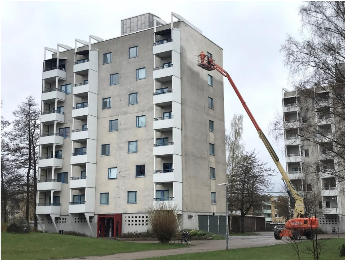
Figur 35 Byggnaderna har kvar delar av sina karaktärsdrag, som konsolerna på taket som bär balkongerna.
