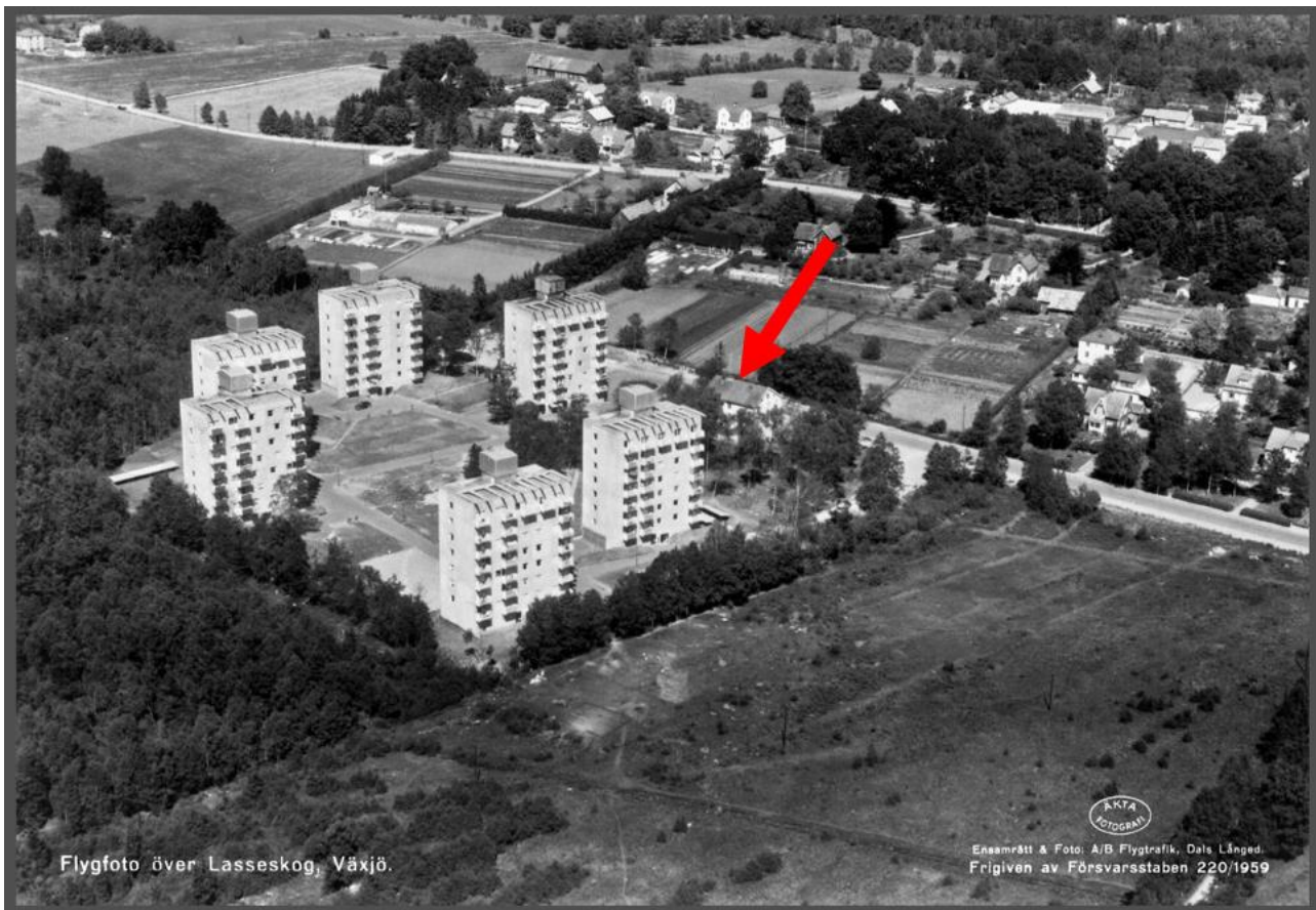
Figur 17 Flygfoto från söder över det nybyggda Lassaskog. Notera den i övrigt lantliga miljön. Det äldre tvåvåningshuset i trä fick till en början stå kvar, utpekad med röd pil. Källa: Kulturparken Småland.
