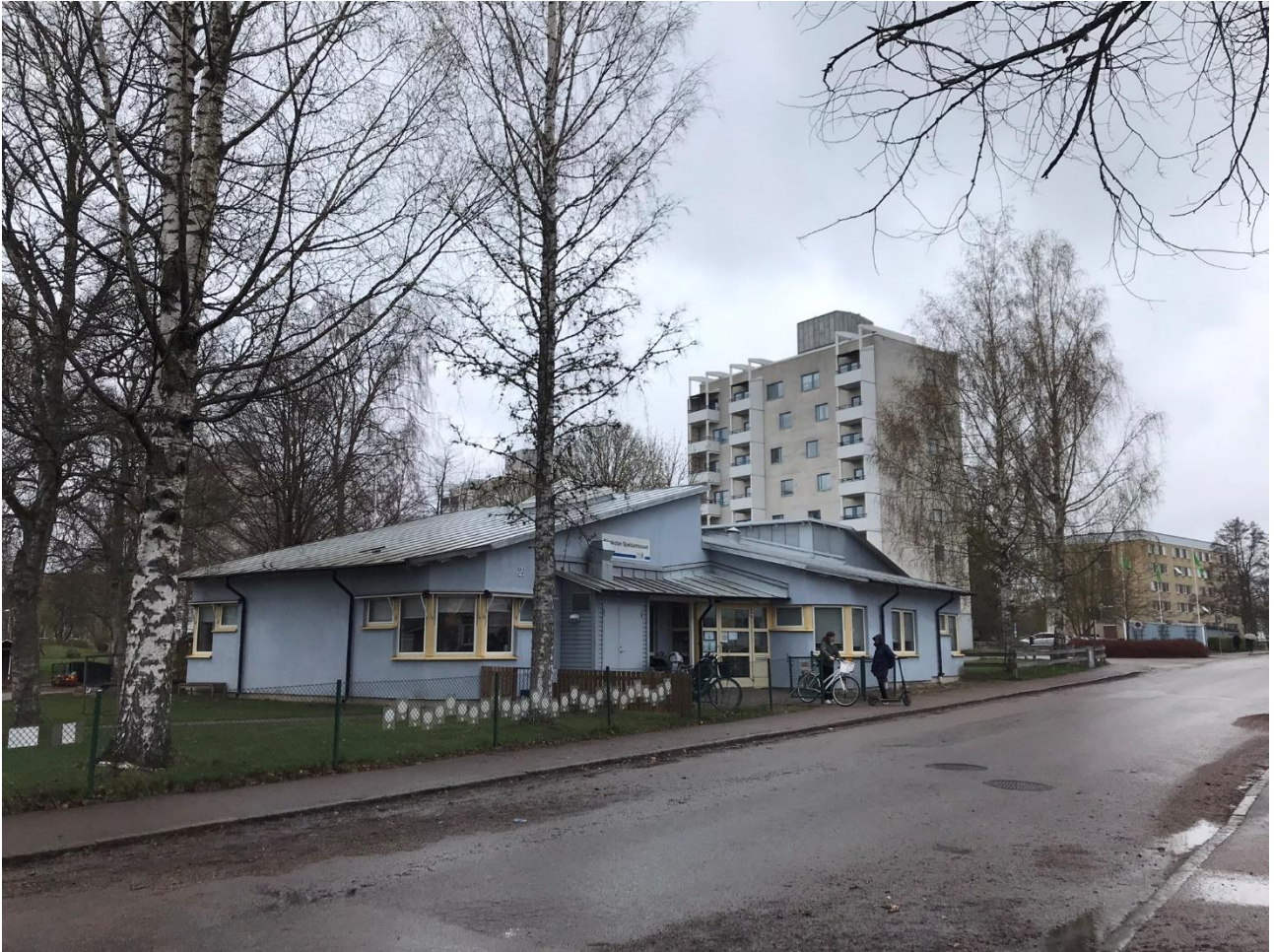
Figur 43 Förskolan Spetsamossen i östra utkanten av kvarteret. Uppförd 1992 som enhetskontor i tidstypisk postmodern stil.
