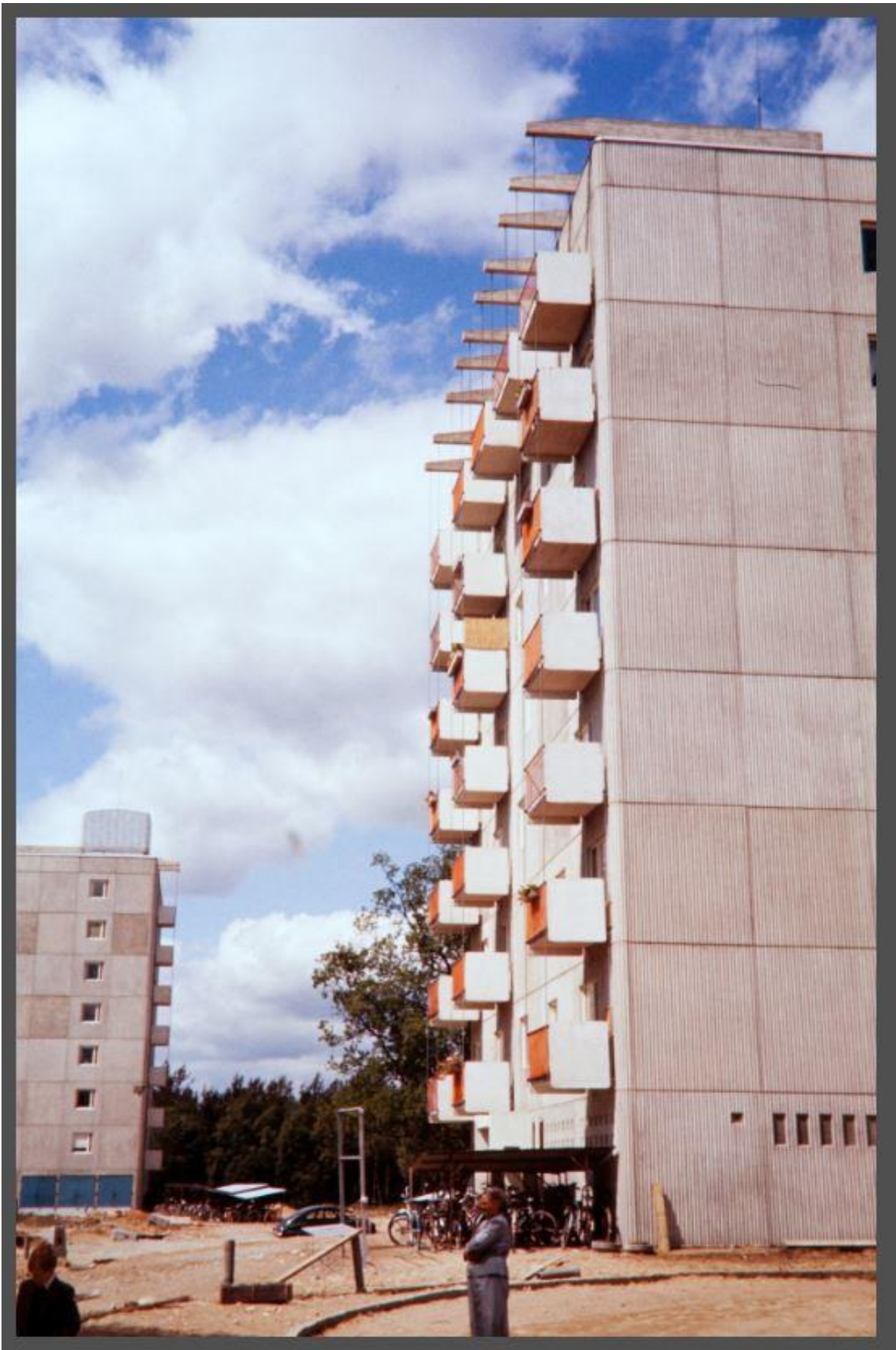
Figur 18 Foto av det nybyggda Lassaskog benämnt "När oskönheten kom till byn". Notera de räfflade betongelementen. Foto Inga Walde. Källa: Kulturparken Småland.
