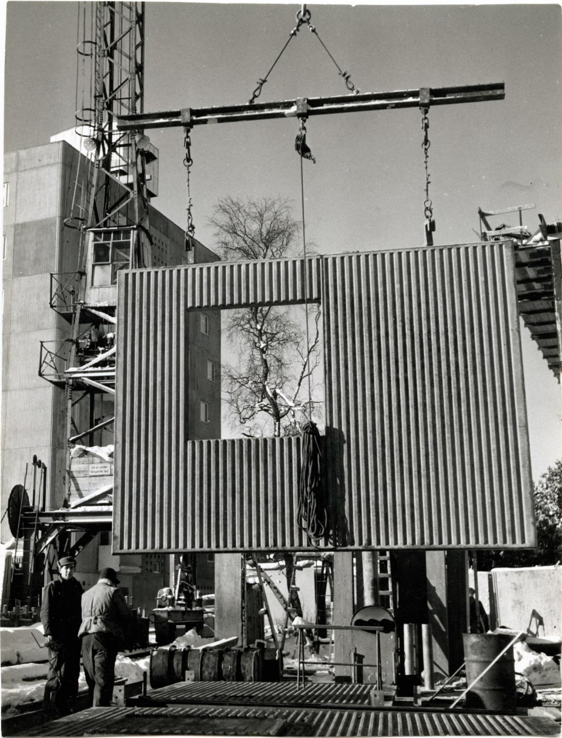
Figur 16 Ett av betonelementen på väg att monteras. Okänd fotograf. Källa: ArkDes
