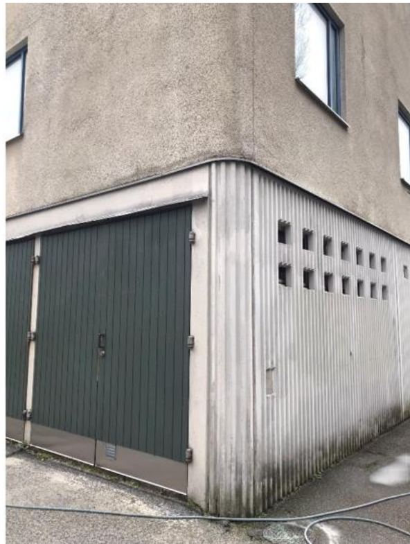
Figur 37 Byggnadernas runda hörn är en karakteristisk detalj. Notera även de ursprungliga garageportarna och betongelementen i sockelvåningen.
