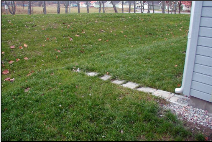
Figur 17. Exempel på ytlig avledning av takvatten mot nedsänkt yta via stuprörsutkastare (SVOA u.å.).
