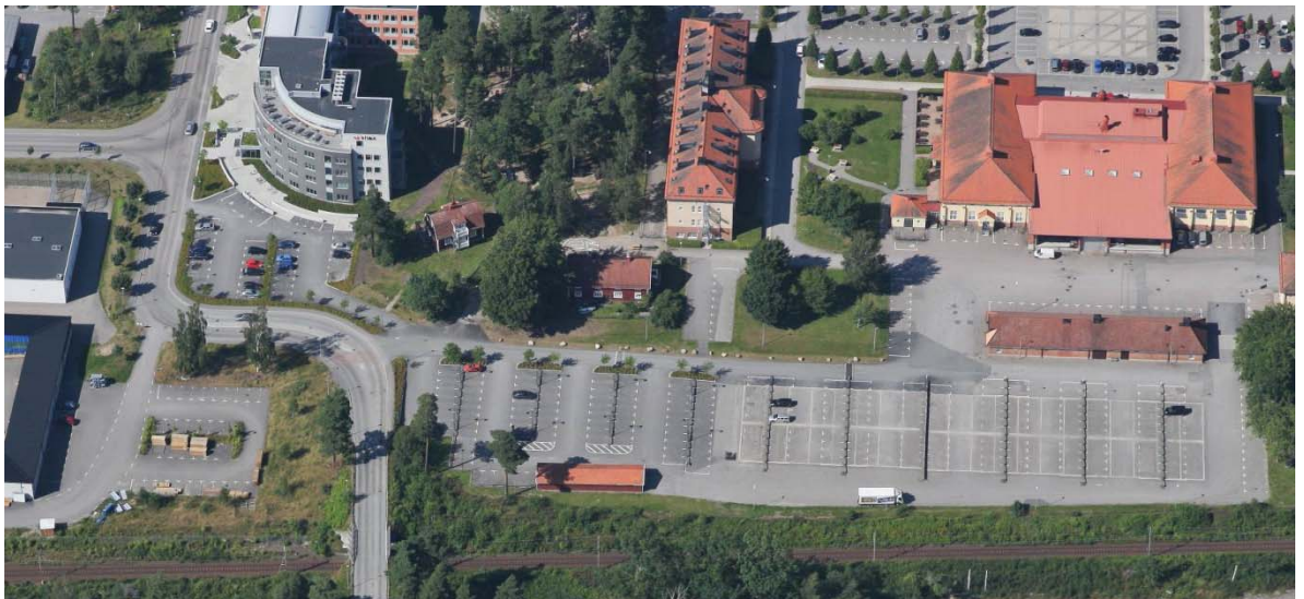
Bild 5 – Bilden visar bron över järnvägen, den större parkeringen inom Norrportens fastighet samt parkering och utfart från Kompaniet 2. Järnvägsområdet som ingår i denna detaljplan rymmer endast ett spår och intilliggande slänter.
