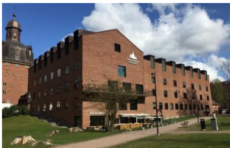
Carlanderska Sjukhuset, Göteborg. Arkitekt: White Arkitekter. Bild: Sweco. Bilden visar tekniska installationer väl integrerade i tak- och fasadgestaltning genom form av takkupor.
