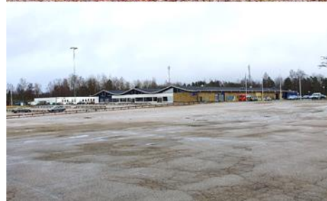
Övre bilden visar byggnaderna vid Råppevallen. Nedre bilden visar handelsbyggnaden på Rimfrosten 1.
