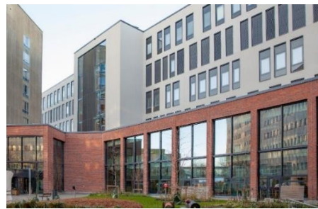
H-huset, Örebro Universitetssjukhus. Arkitekt: Sweco/AART Architects. Bild: Sweco. Bilden visar ett exempel där teknikvåningen (våning fem) är inkorporerad i fasadgestaltningen som helhet.
