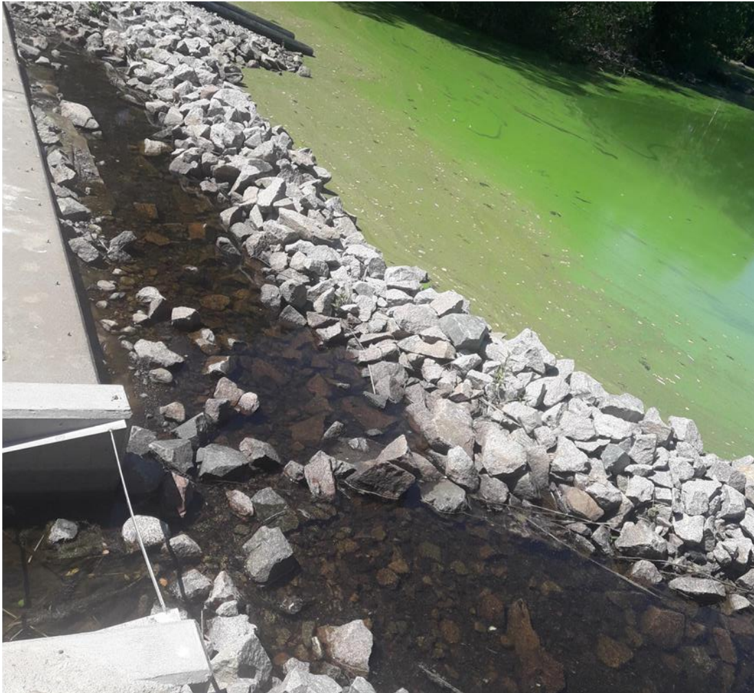
Foto 5. Dammen mellan Bergundasjöarna i juli 2018. Notera den påtagligt bättre vattenkvaliteten i Södra Bergundasjön (närmast i bild). Dammen har två syften: att hindra bakåtströmning av vatten från Norra Bergundasjön till Södra Bergundasjön i samband med mycket låga flöden och/eller blåst, samt -viktigare- att minimera migration av fisk. En permeabel stenvall uppfördes under våren 2018 istället för 15 mm galler, eftersom det uppstod problem med dödlighet av framför allt abborre på gallret pga för höga vattenhastigheter genom detsamma.
